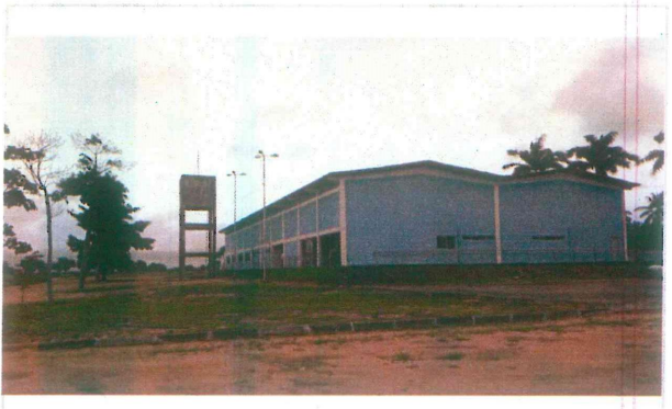
Vista geral da área a ser implantada o Refeitório
